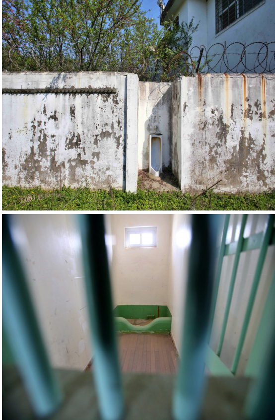
〈그림 11〉 운동장에 설치된 변기(위)와 독방 내부의 화장실(아래)
